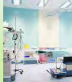
Instalaciones Salas Limpias
